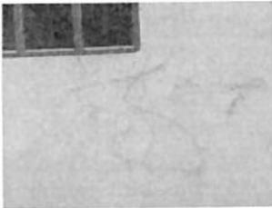
(a) Daños leves en estructura de albañilería confinada (G1)
