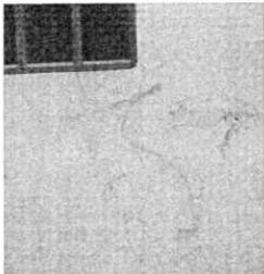
(a) Daños leves en estructura de albañilería confinada (G1)
